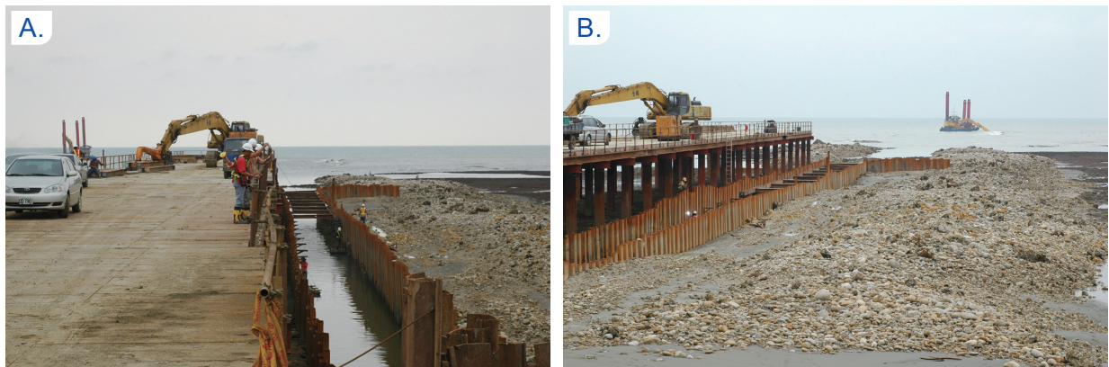
▲ 圖八、A. 2007 年 5 月輸氣管線工程直接穿過藻礁區，將寬深 4m×4m 的礁體完全開挖。B. 挖出的礁體就放置於旁邊的活藻礁上，導致周圍的藻礁也一併死亡。
