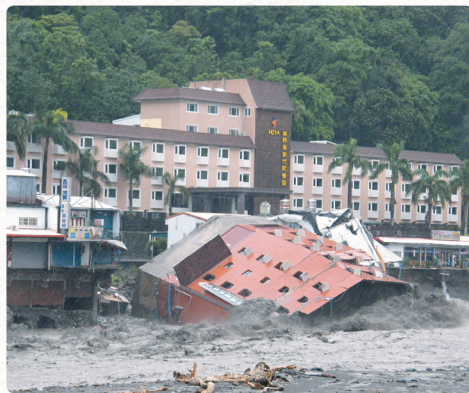
▲ 莫拉克颱風入侵，臺東金帥飯店整棟建築墜入溪水中。
